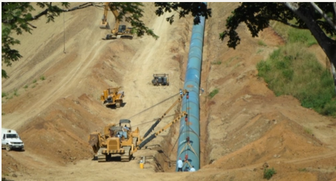
Tendido de tuberías en corredor de obra
