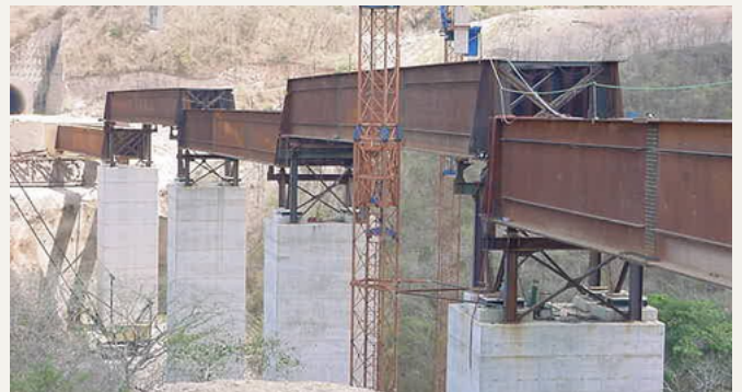
Montaje de estructura de viaducto
