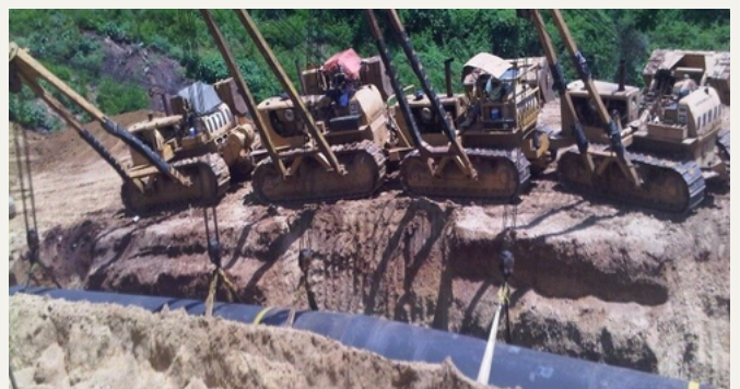
Bajado de tubería con side booms
