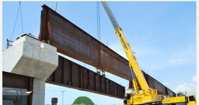
Izaje de viga metálica
