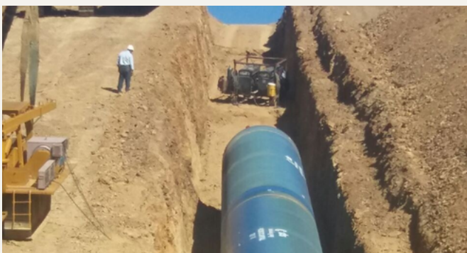
Manipulación de tubería
