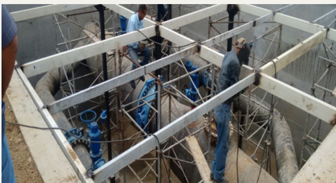
Construcción de obra civil
