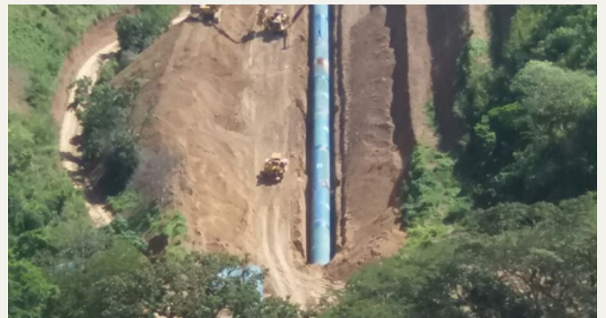
Tubería en terreno de pendiente
