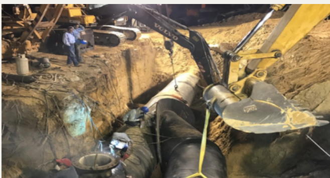
Intervención de tuberías en campo
