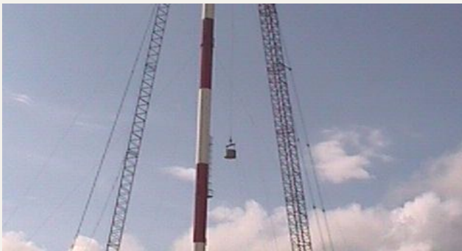
Operación de izaje
