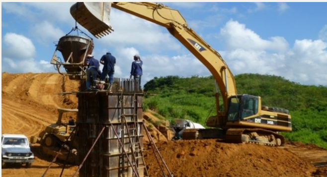
Excavación y obra civil
